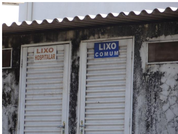
Figura 4-LV: Armazenamento dos resíduos de serviço de saúde em clínica particular
