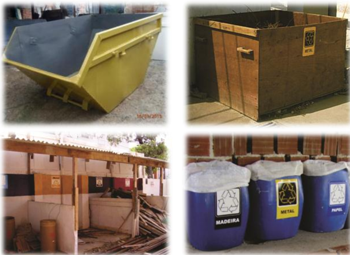
Figura 6-LI: Formas de acondicionamento temporário e final para Resíduos da Construção Civil em canteiros de obra
