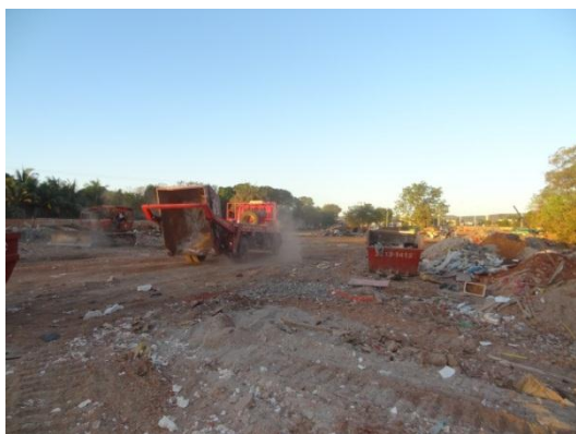
Figura 4-LIX: Área de disposição final dos RCD
