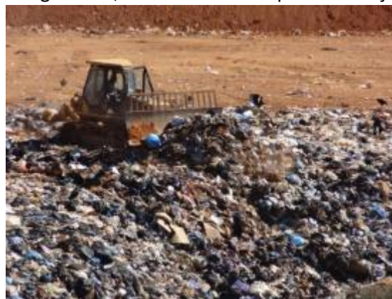
Figura 4-XXVIII: Trator esteira operando na frente de trabalho do aterro sanitário.
