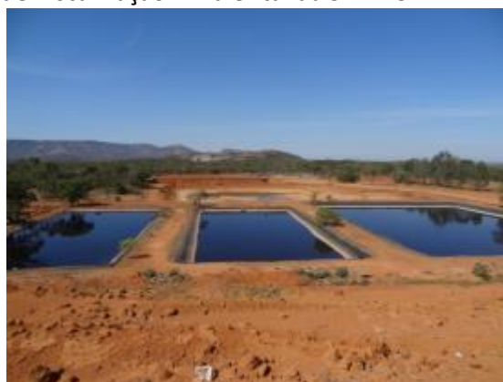
Figura 4-XXVI: Lagoas de tratamento de lixiviados
