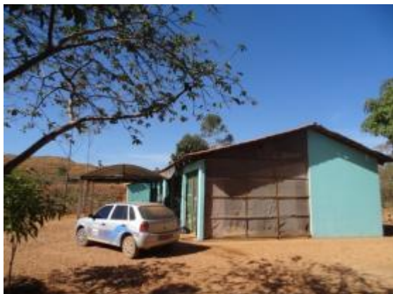
Figura 4-XXIII: Estrutura de apoio no aterro sanitário
