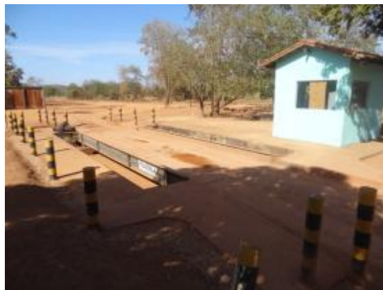
Figura 4-XXIV: Balança para pesagem dos veículos de coleta de resíduos
